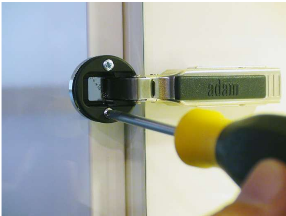
Bild 15. Abdeckkappe an Gelenkbändern für Vollglastüren verschrauben
