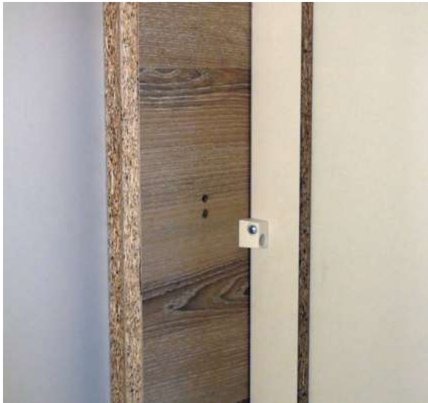
Bild 7. Montage Frontpaßstück.
