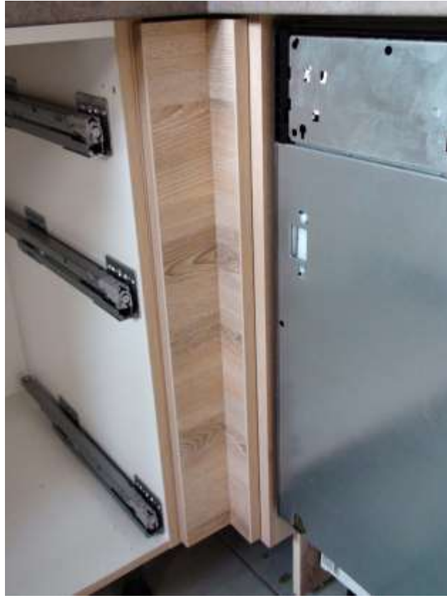
Bild 6. Einbau Eckpaßstück.
