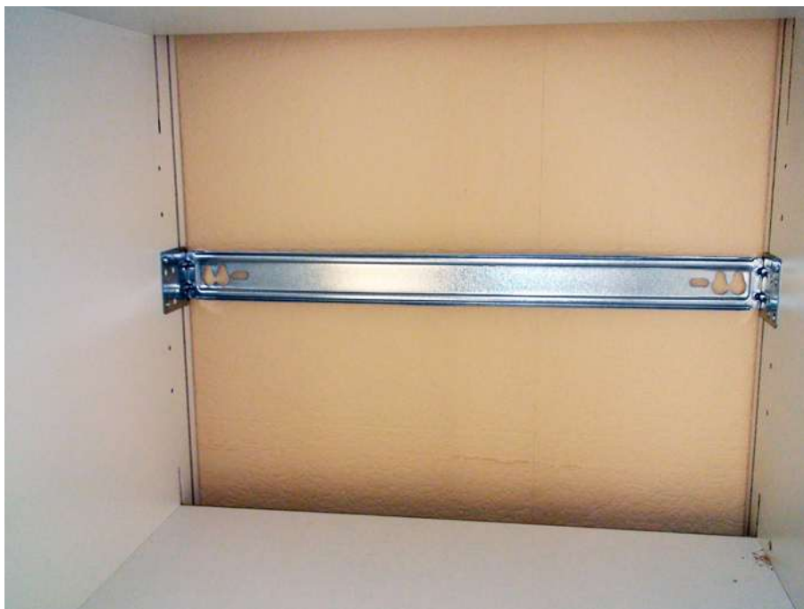
Bild 26. Montageschiene für Geräteumbauschrank.
